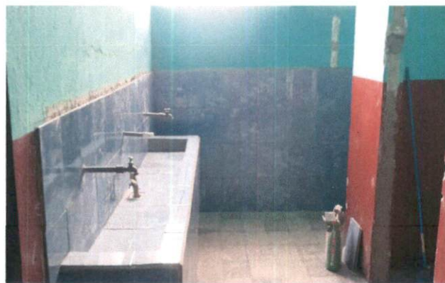
Foto 4: Reozamiento de servicios sanitarios
