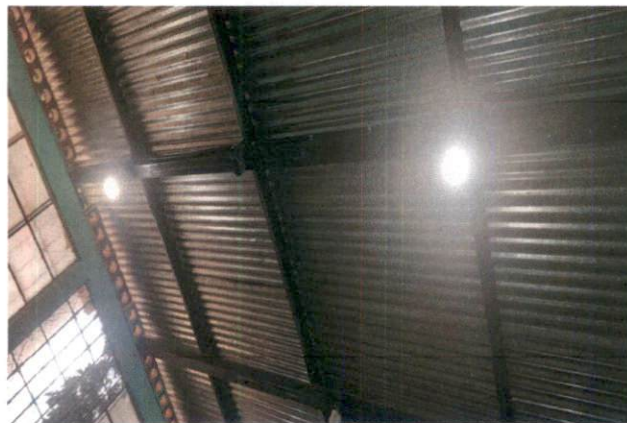
Foto 2: Remozamiento de luz electrica
